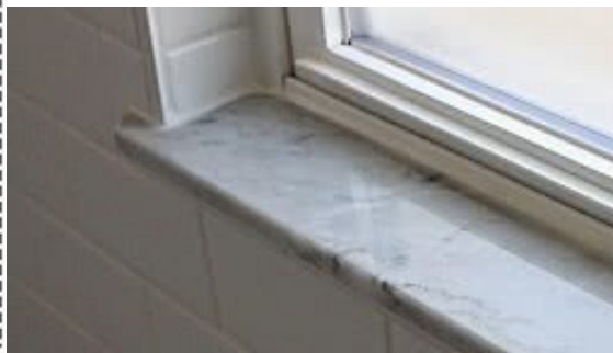
Detalhe de instalação de pingadeira. Imagem ilustrativa.
